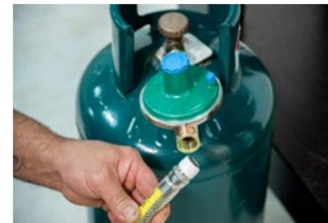
**2.** Raccordez le tuyau flexible au régulateur de pression.
