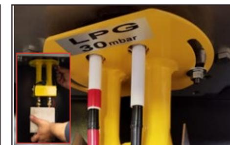
**4 - Démontez les boulons de fixation du brûleur**
