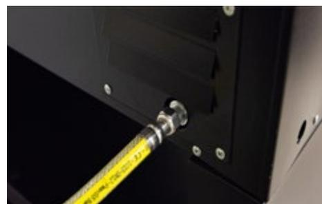
**3.** Vissez le tuyau flexible au four et utilisez une clé spéciale pour un serrage parfait.
